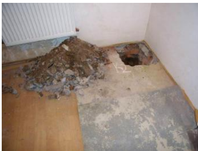
Kopaná sonda K2 s přizdívkou stěny
